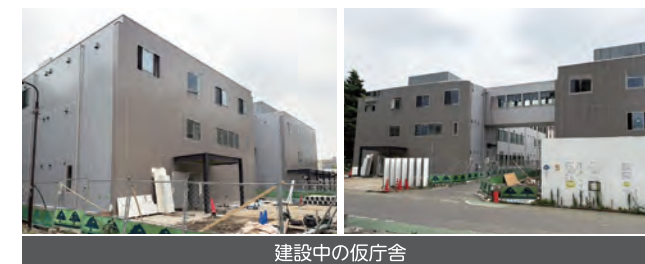
建設中の仮庁舎
