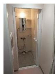
【警察学校 女性寮シャワー室増設】
